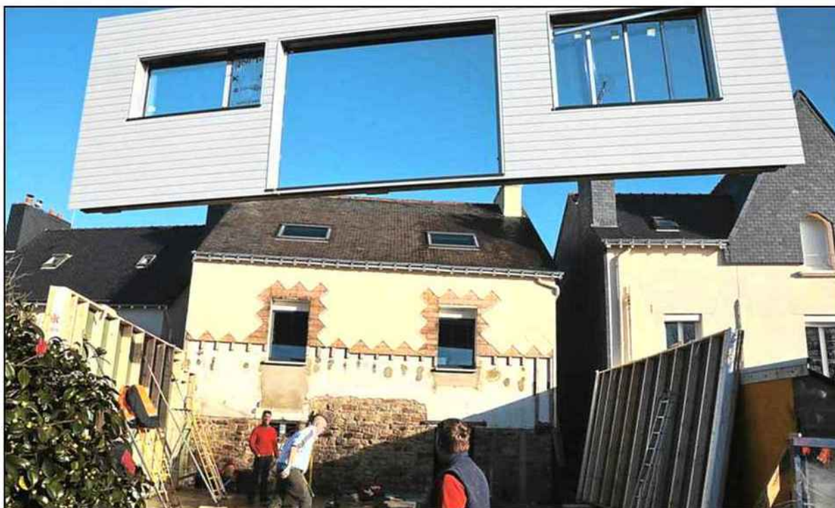
En 30 minutes, la maison a gagné 57 m 2 hier matin. Les panneaux en bois peints ont été réalisés à l'usine, sur mesure et fixés sur une dalle de béton réalisée au préalable.
